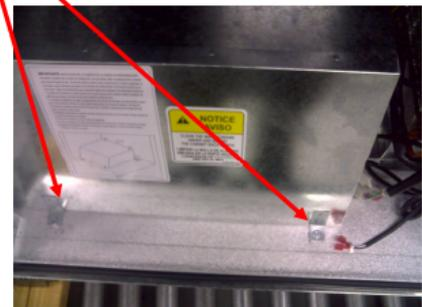
4. retirar la cubierta dentro del gabinete del cable de entrada de voltaje de alimentación que esta fijada con 2 tornillos de ¼"
