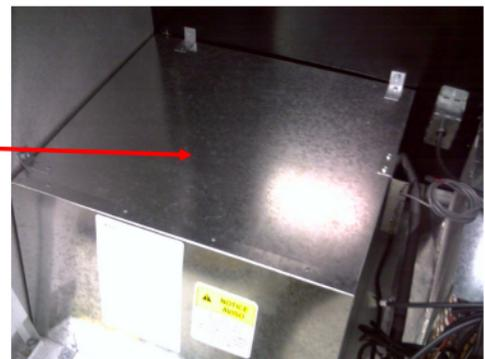
7. el sistema de refrigeración esta atornillado con 3 o 4 tornillos de 3/8" en la base o piso del gabinete y se deben retirar de preferencia con un dado y extensión.
