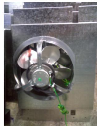
Ventilador de evaporador vista trasera
